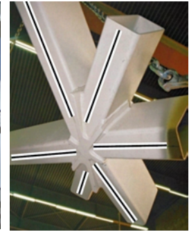
Abbildung 8: Links: Złote Tarasy, Warschau (Design Jerde Partnership International, Ausführung Waagner-Biro Stahlbau). Stahl-Glas-Konstruktion, die einem Dreiecksnetz folgt. Mitte: Detailansicht. Rechts: Ein Knoten, der mehrere Träger verbindet, wird aus Trägerteilen und einem zentralen durch Plasmaschneiden aus einer dicken Stahlplatte erzeugten Stück vorgefertigt. Man kann deutlich erkennen, dass die Symmetrieebenen der an dem Knoten beteiligten Träger keine eindeutige Knotenachse definieren (d.h. der Knoten ist nicht torsionsfrei).
