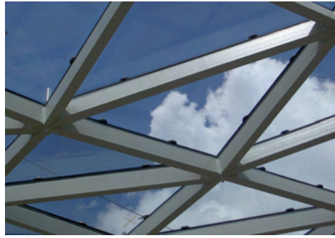
Abbildung 8: Links: Złote Tarasy, Warschau (Design Jerde Partnership International, Ausführung Waagner-Biro Stahlbau). Stahl-Glas-Konstruktion, die einem Dreiecksnetz folgt. Mitte: Detailansicht. Rechts: Ein Knoten, der mehrere Träger verbindet, wird aus Trägerteilen und einem zentralen durch Plasmaschneiden aus einer dicken Stahlplatte erzeugten Stück vorgefertigt. Man kann deutlich erkennen, dass die Symmetrieebenen der an dem Knoten beteiligten Träger keine eindeutige Knotenachse definieren (d.h. der Knoten ist nicht torsionsfrei).
