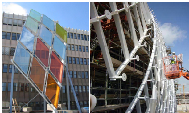
ABBILDUNG 2: Yas Island Hotel. Links: Testaufbau am Werksgelände von Wagner-Biro Stahlbau, Wien. Rechts: Montage.
