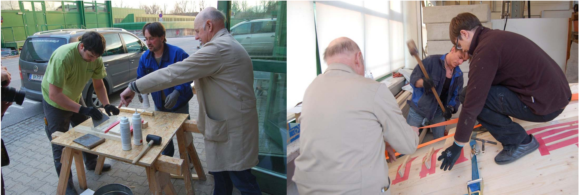
Bestreichen der Kertos mit Kleber und Einschlagen in die Schlitz
